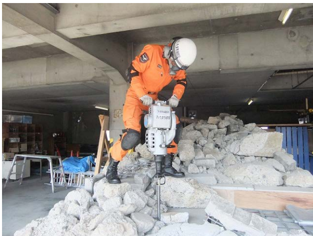
【削岩機取扱訓練】
