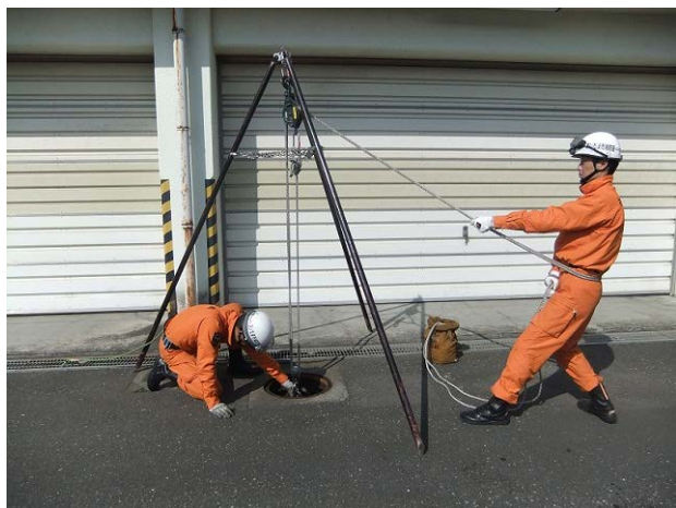
【マンホール救助器具訓練】
