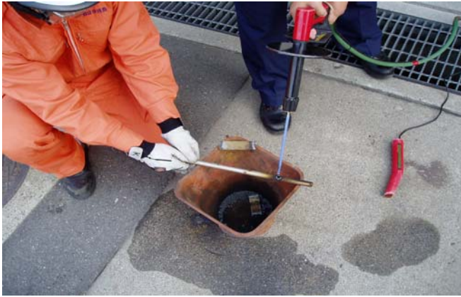
アークエアーにてパイプを切断する訓練状況
