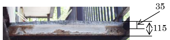
通路コンクリート床
