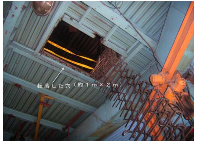
1階からみたピットの状況(高さ約5m)
