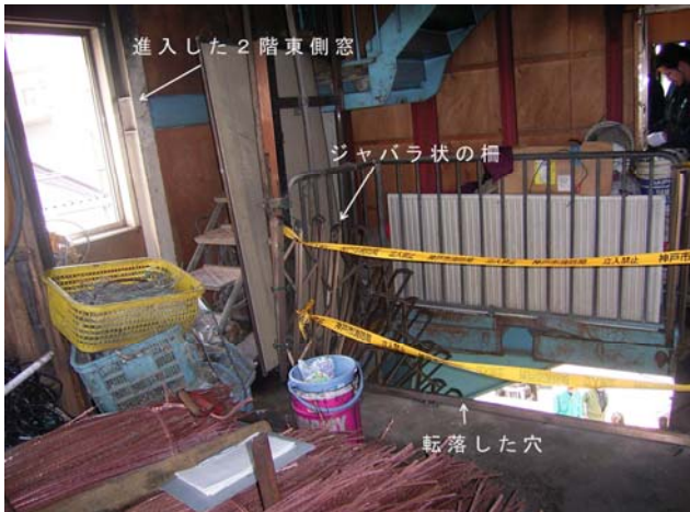
2階ピット付近の状況
