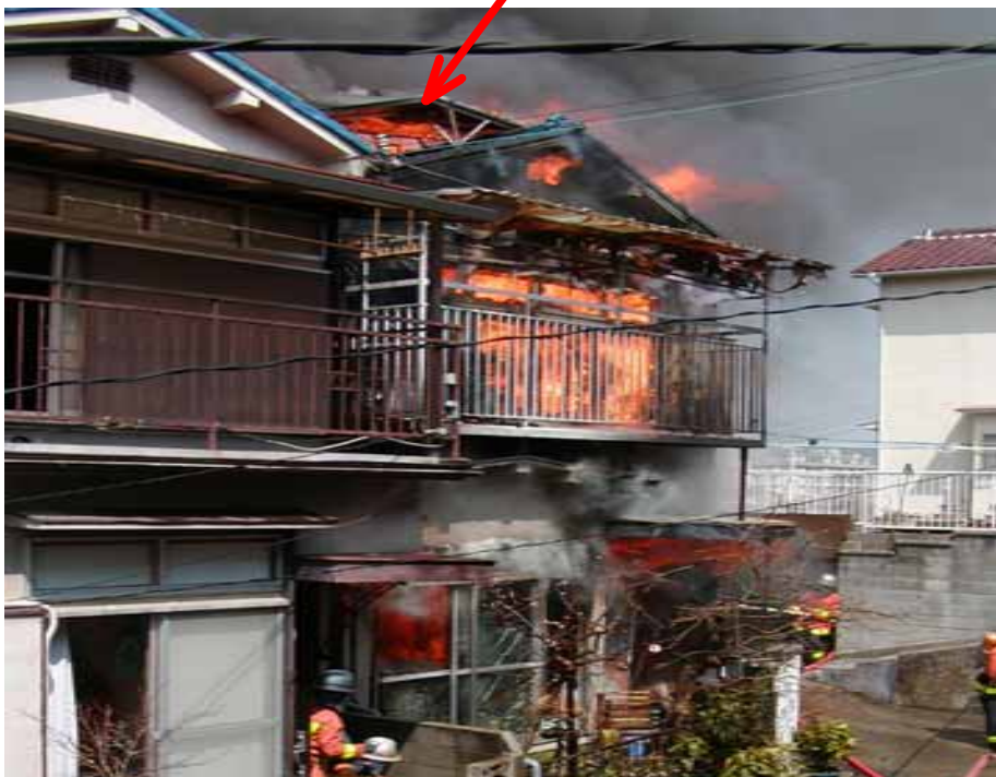
火災最盛期の屋根上ソーラーシステム
