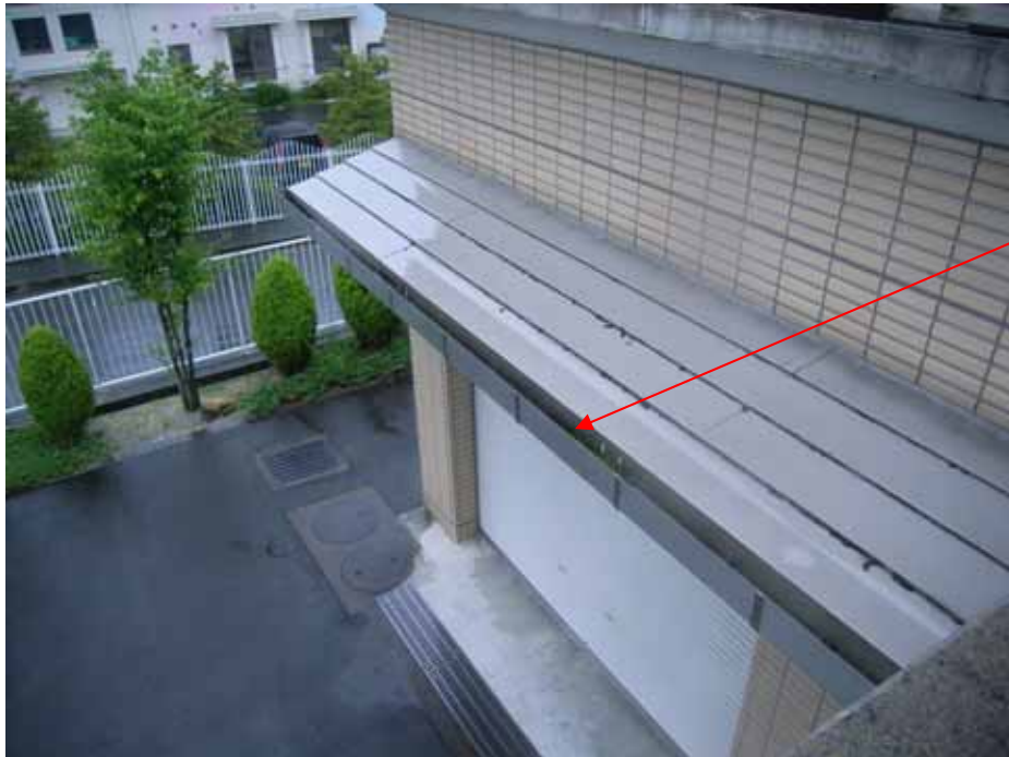
ひさしに取り付けられている樋
