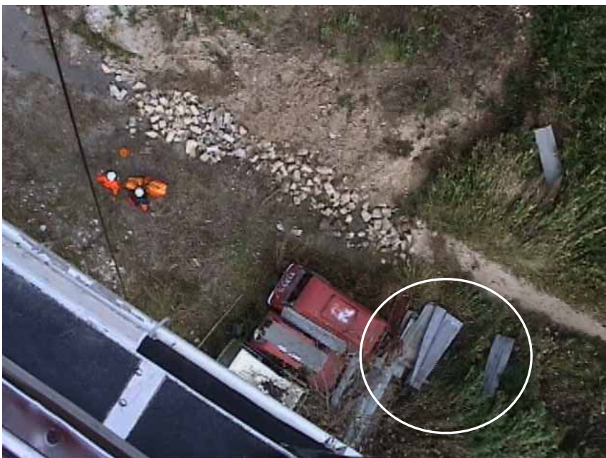
飛散したトタン板が積上げてあった場所
