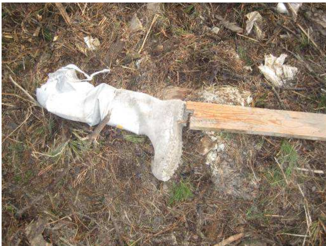
釘踏み抜き状況
