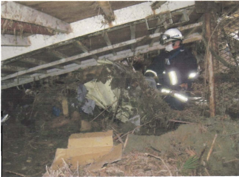
プレハブの下の状況
