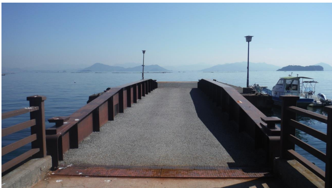
栈橋を東（海側）へと進んだ位置
