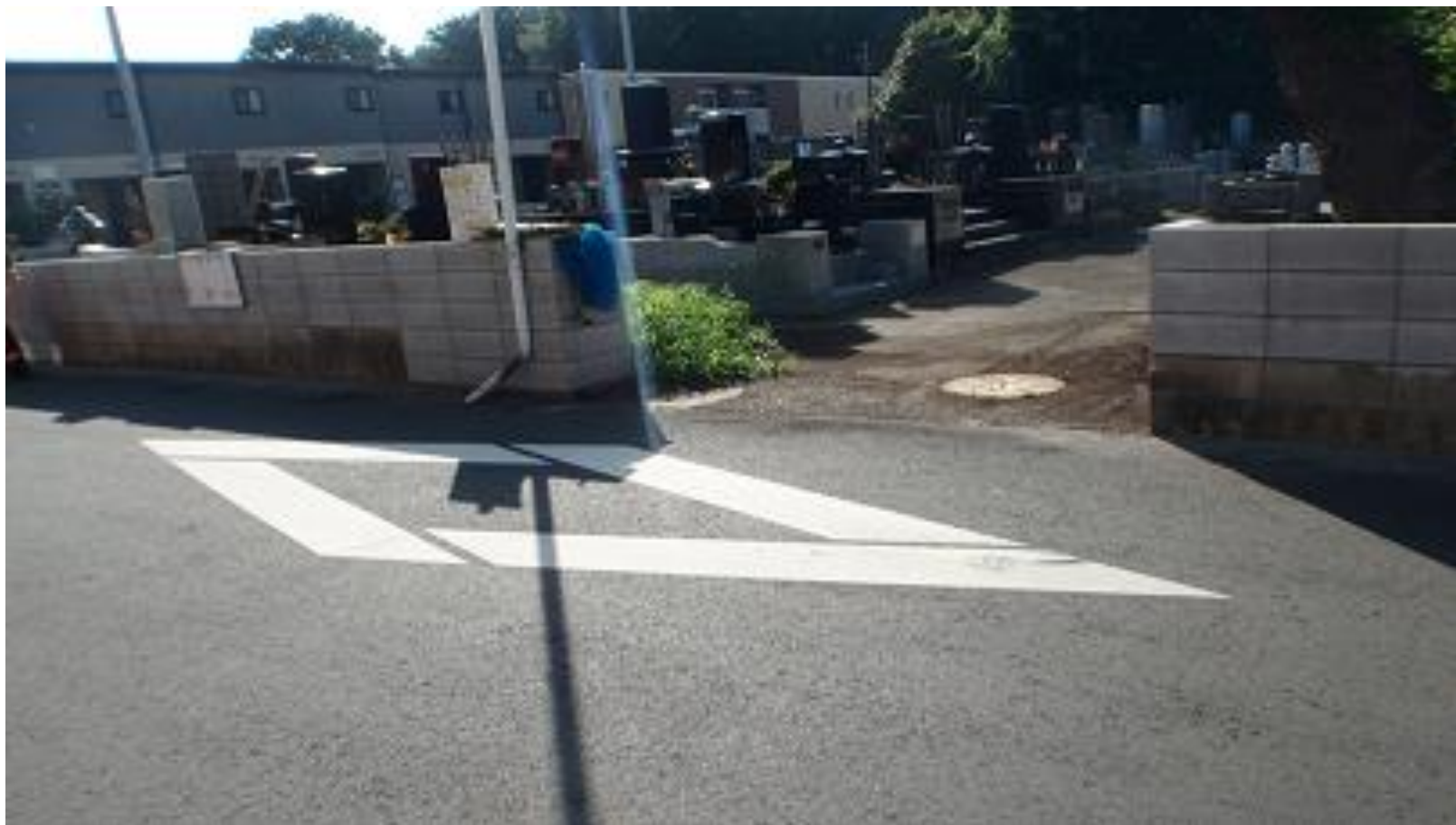
現場を東側から撮影
