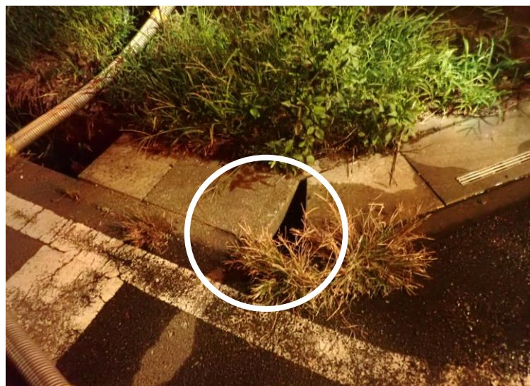
側溝の間隙部分を撮影
